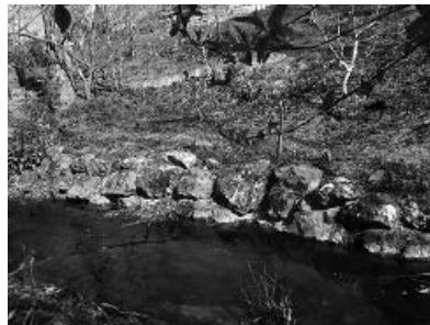
Ein Beispiel, wie eine gute Uferverbauung aussehen soll
