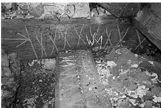
In der Decken- und Dachkonstruktion müssen Teile von feuchten Balken dringend ersetzt werden
