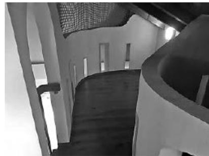
de der Bereich neu gestrichen, die Mauernischen auf der Wandinnenseite mit Acrylglasscheiben verschlossen und Schutznetze gegen eine eventuell bestehende Absturzgefahr zwischen Wandoberkante und Dachunterseite montiert. Durch all diese Maß-
