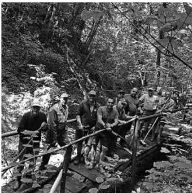
Der Bautrup auf einer neu errichteten Brücke im mittleren Wegabschnitt der „Lebergasse“
