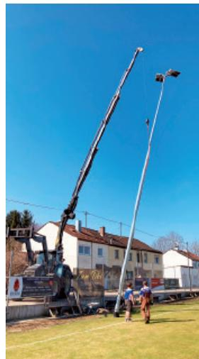
Die alten 2000 W Flutlichtstrahler wurden von der Firma E&S Elektro gegen Flutlichtstrahler in LED Technik getauscht. Dadurch sparen wir nicht nur einiges an Strom ein, sondern wir konnten auch noch insgesamt vier zusätzliche LED Strahler montieren lassen, um den Kleinfeldplatz rechts und den Ausweichplatz links ein wenig mit zu beleuchten, damit hier ein Training möglich ist. Die Strahler sind bereits montiert und der Schaltkasten entsprechend umgebaut.
