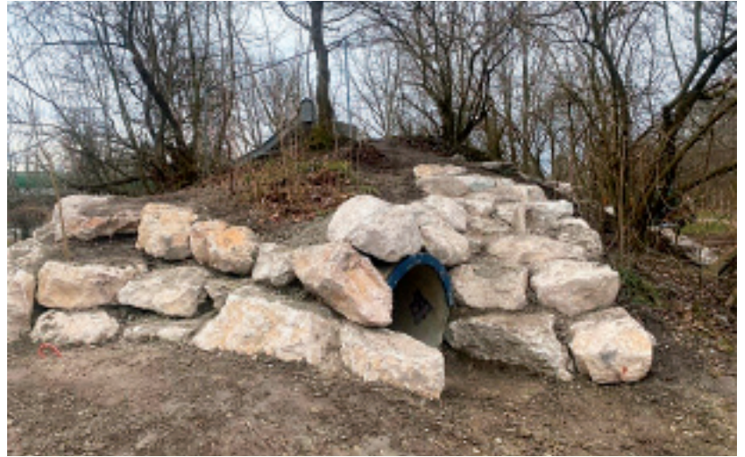
Neubefestigung des Rutschenhügels
