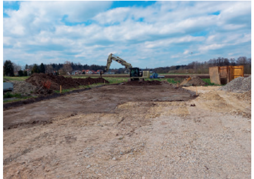
Regenwasserableitungskanal Richtung „Graben an der Pfaffenhofener Straße“
