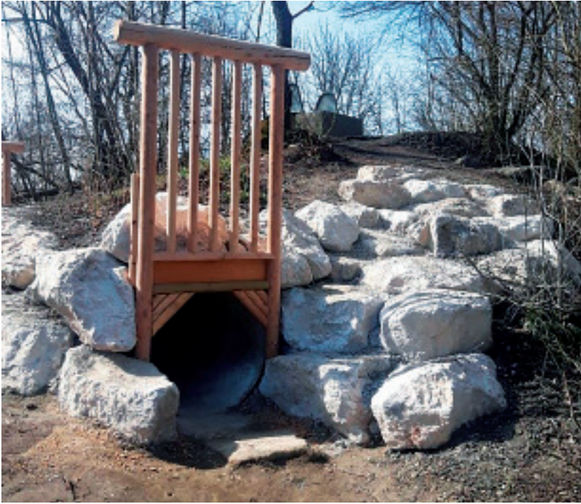
Erneuerung der Absturzsicherung aus Lärchenholz
