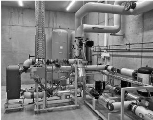
Wärmeauskopplung Lohen mit Wärmeübergabestation als Systemtrennung
